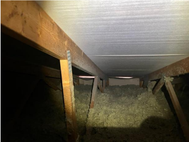
Tuulenohjauslevyt kiinnitetty.
