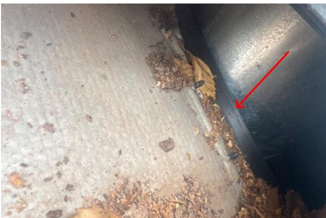
Läpivienneissä käytetty aluskaterenkaita. Asianmukaiset.
