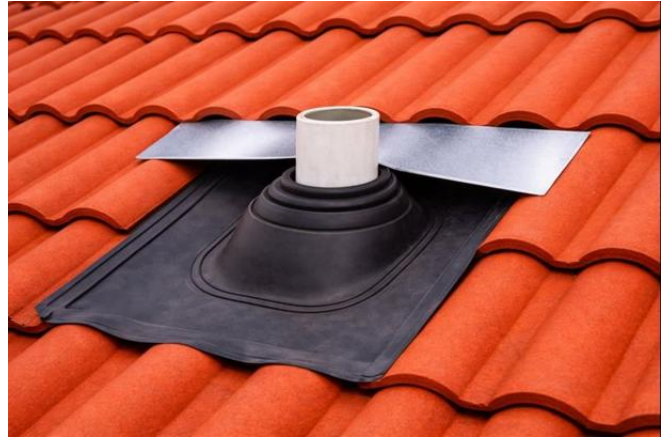
Uusi vedenohjauslevy asennettu.
