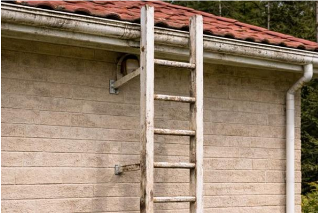
Seinätikkaat leväiset. Suositellaan pesua muun työn yhteydessä.
