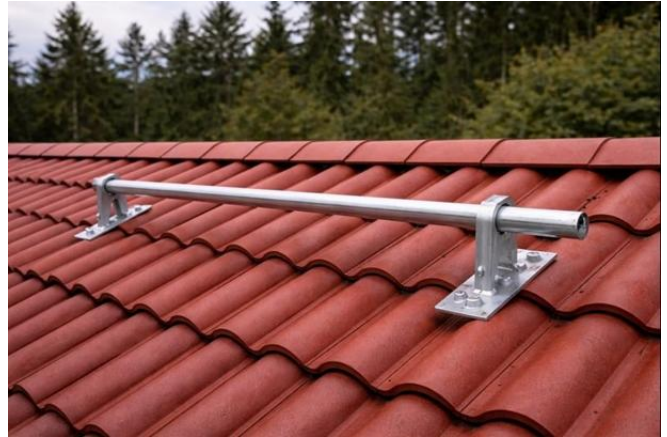
Lumiesteet uusittu. Asennettu apuruoteet.
