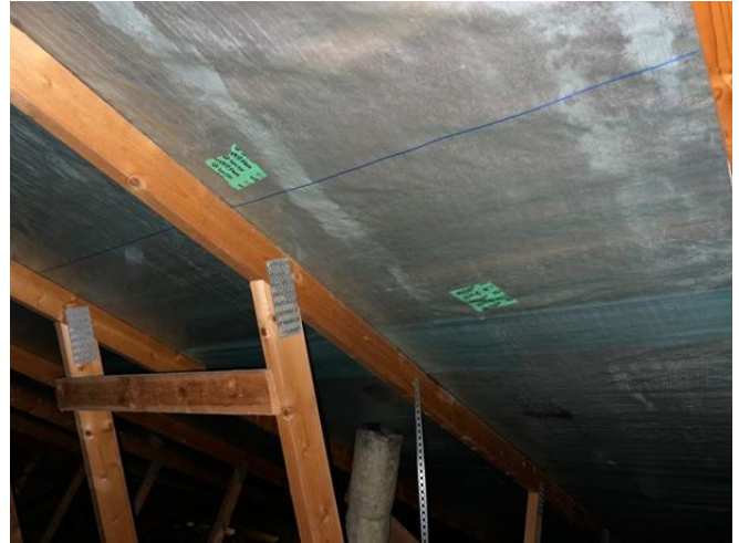
Reiät teipattu Sitkoflex höyrinsulkuteipillä.
