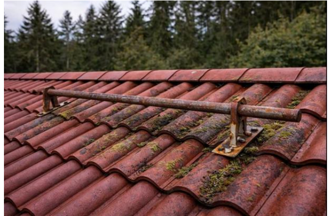
Lumiesteet ruostuneet. Suositellaan uusimaan lumiesteet.
