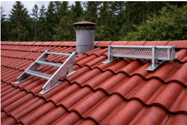
Lapetikkaat ja kattosillat uusittu. Asennettu apuruoteet.
