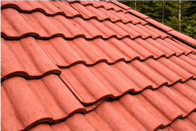
Reikä korjattu katolla.
