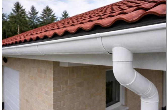
Sadevesikourut ja syöksyt tyhjennetty ja pesty.
