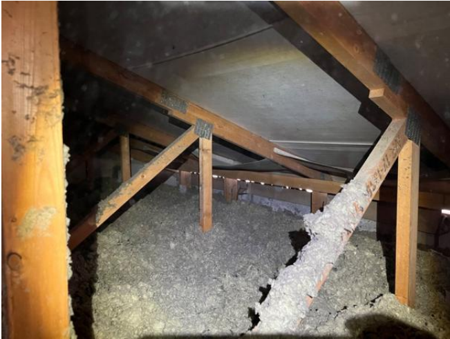
Yläpohjarakenteet terveet. Villaa riittävästi.
