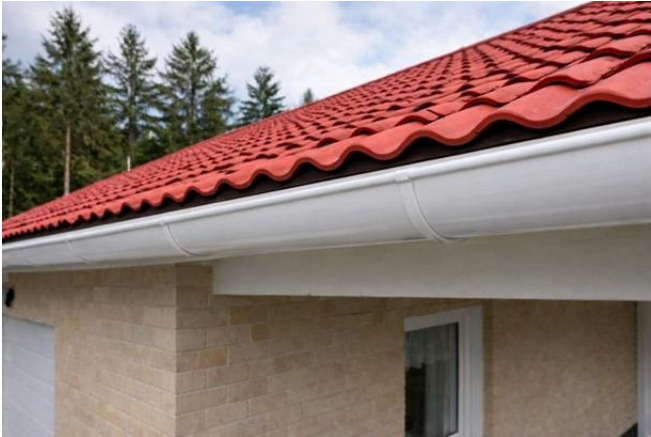
Sadevesikourut ja syöksyt tyhjennetty ja pesty.
